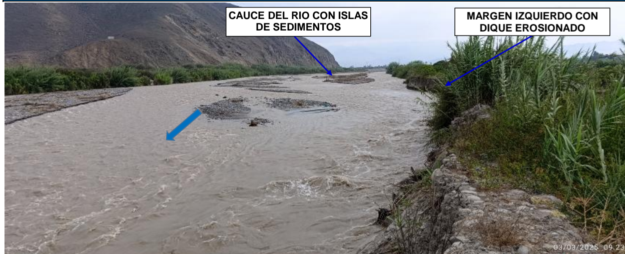
FIGURA N°01: TRAMO CRÍTICO EN EL RÍO CHANCAY HUARAL CON EL CAUCE COLMATADO Y PRESENCIA DE ISLAS DE FLUJO DE DETRITOS, MARGEN IZQUIERDO ES EL SECTOR MANCHURIA CON EL DIQUE EROSIONADO Y EN TODA LA MARGEN DERECHA DE ESTE TRAMO SE ENCUENTRA EL CANAL CD SALINAS ALTO.
