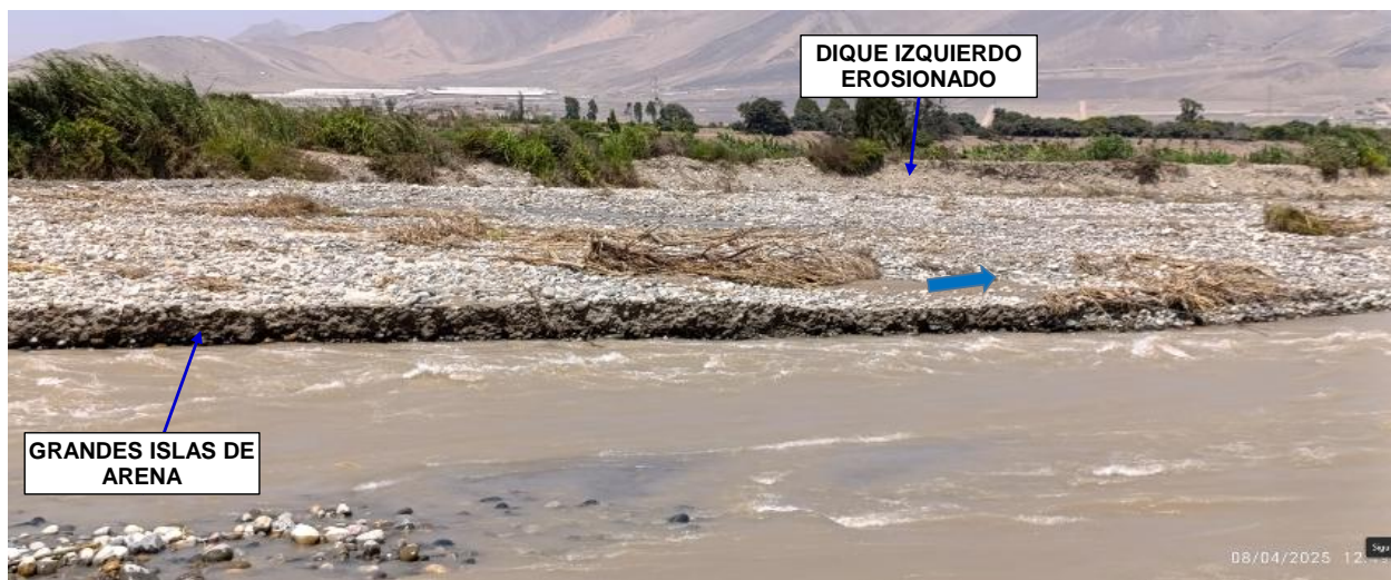
FIGURA N°04: RIO CHANCAY HUARAL, CON EL DIQUE IZQUIERDO CONFORMADO DE MATERIAL PROPIO CON EROSION AVANZADA Y EL CAUCE DEL RIO COLMATADO DE FLUJO DE DETRITOS.
