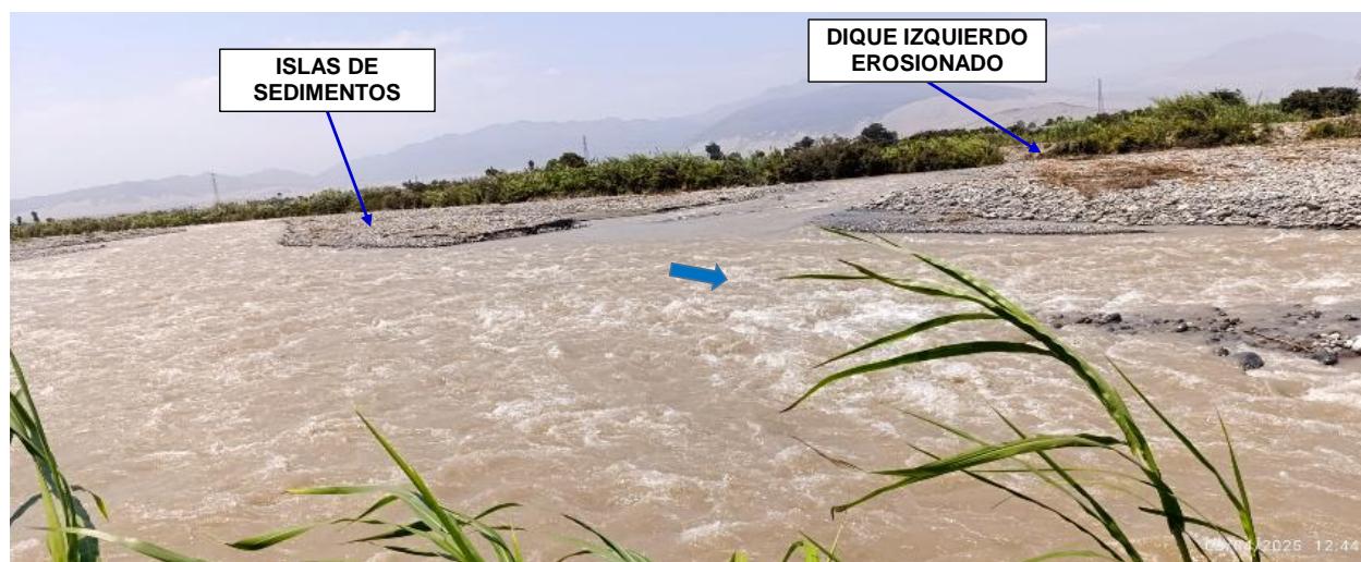
FIGURA N°03: RIO CHANCAY HUARAL, SECTOR MANCHURIA CON EL DIQUE EROSIONADO Y EL CAUCE CON PRESENCIA DE ISLAS MUY PRONUNCIADOS QUE DESVIA EL CAUDAL HACIA LAS MARGENES CAUSANDO EROSION A LOS DIQUES.
